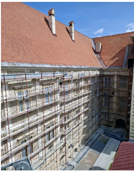
Das mächtige Gerüst im Museums- hof wurde im Oktober abgebaut.
